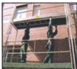
3. Platformų su/be liuku ir kopėčiomis, saugiam ir greitam patekimui, įrengimas.
