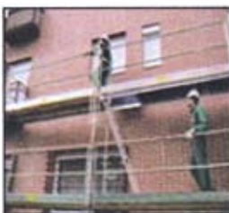
4. Pakilimas į kitą aukštą su įrengta apsauga.
