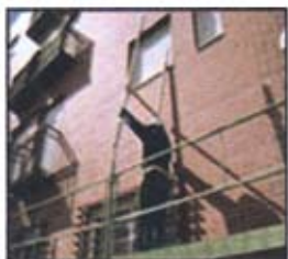
1. Vertikalaus modulio su perėjos segmentu montavimas.
