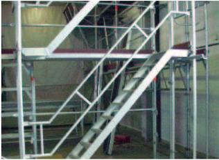
Bequemer Gerüstaufstieg und Materialtransport mit Alu-Treppen und Geländern. Als Fußpunkt für die unterste Treppe bildet die Fusstraverse eine sichere Auflagerung.
