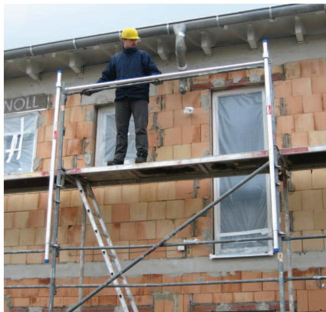
Beim Aufstieg auf die jeweils oberste Gerüstlage und bei der anschließenden Montage der Vertikalrahmen und Geländer kann Absturzgefahr bestehen.
